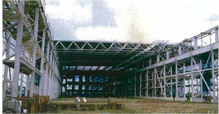
写真2 バイブトラス大屋根のスライド工法で施工中の工場
